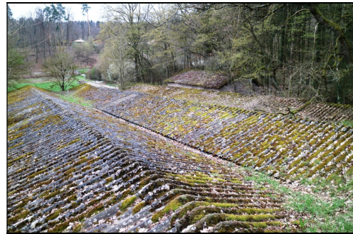
Dachflächen der Gebäude
